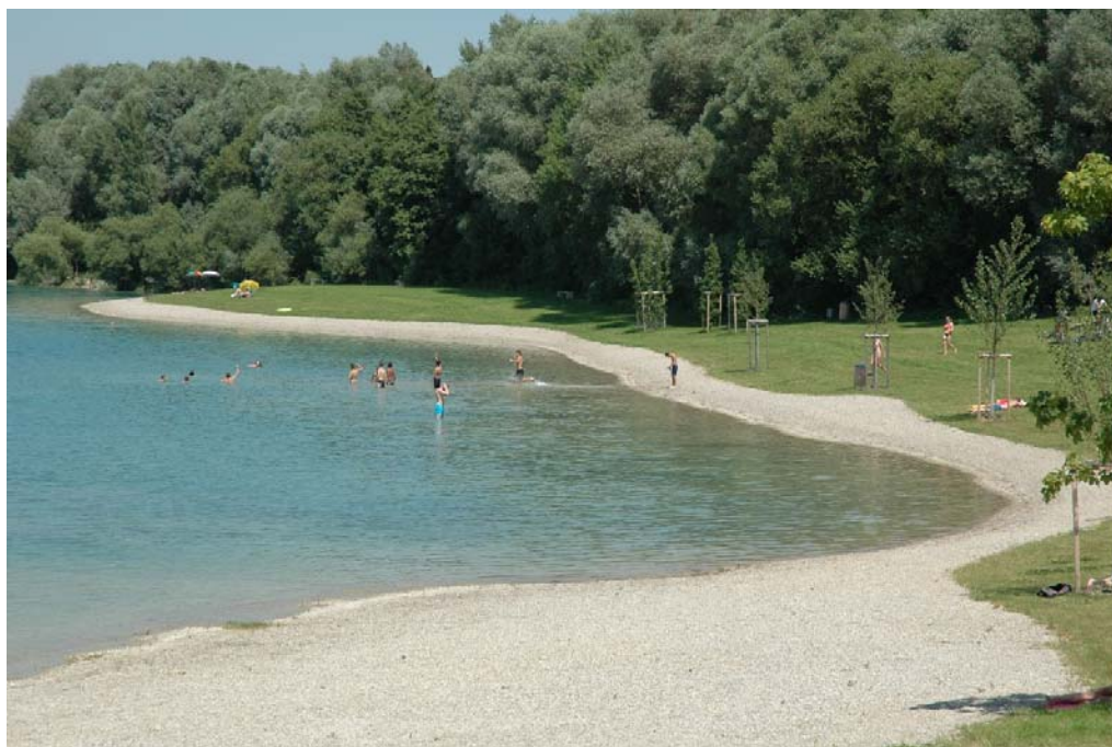
Pullinger Seen 2. Bauabschnitt, östl. Bereich
